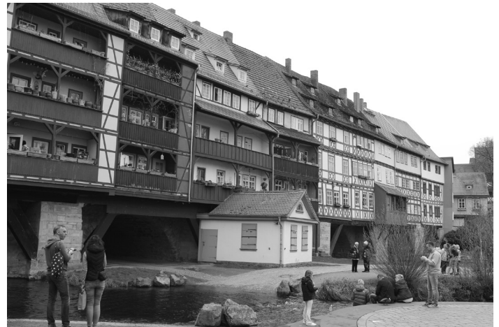
Die Krämerbrücke von außen.
