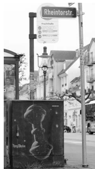
Der Verteilerkasten unweit der Fruchthalle
