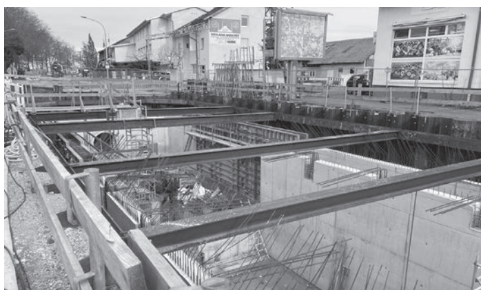
In der nun beginnenden zweiten Bauphase des neuen Regenüberlaufbeckens in der Raentaler Straße stehen Kanalarbeiten im Fokus. Gleichzeitig geht der Bau des Beckens weiter. Foto: Stadt Rastatt/Janis Dumas
